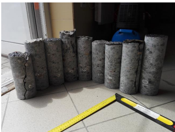
Rys.1.2. Widok zestawu pobranych odwiertów z nawierzchni
