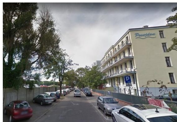
Fot. 18 DK11, sanatorium w Kołobrzegu, powiat kołobrzeski
