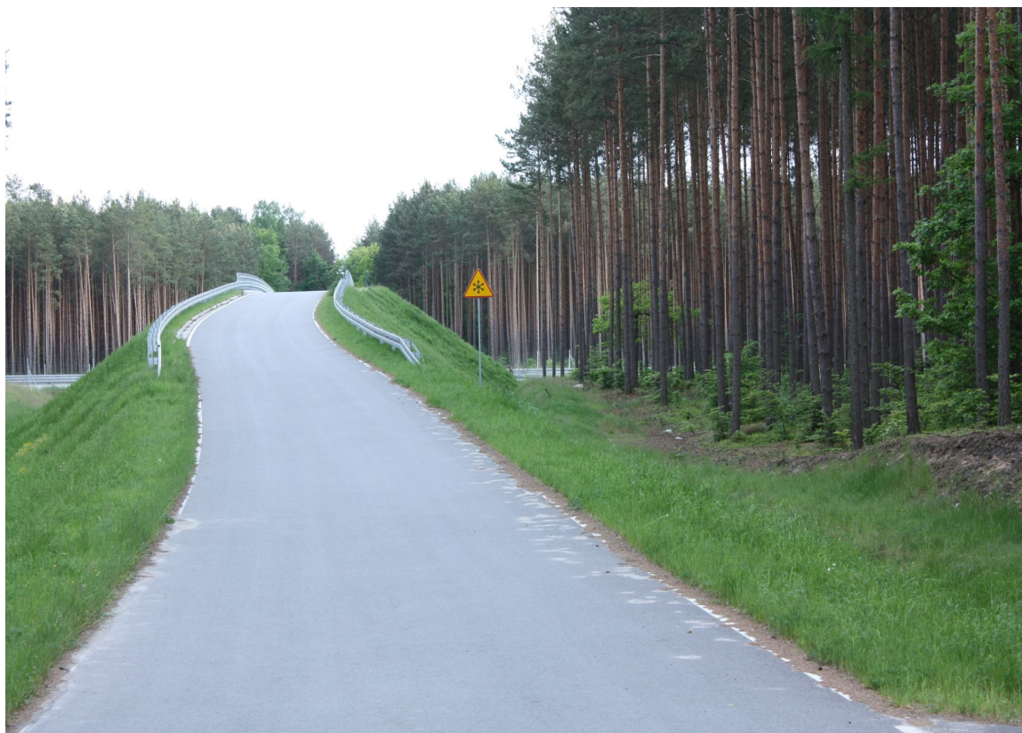
Fot. 13. Przykładowy przejazd nad autostradą
