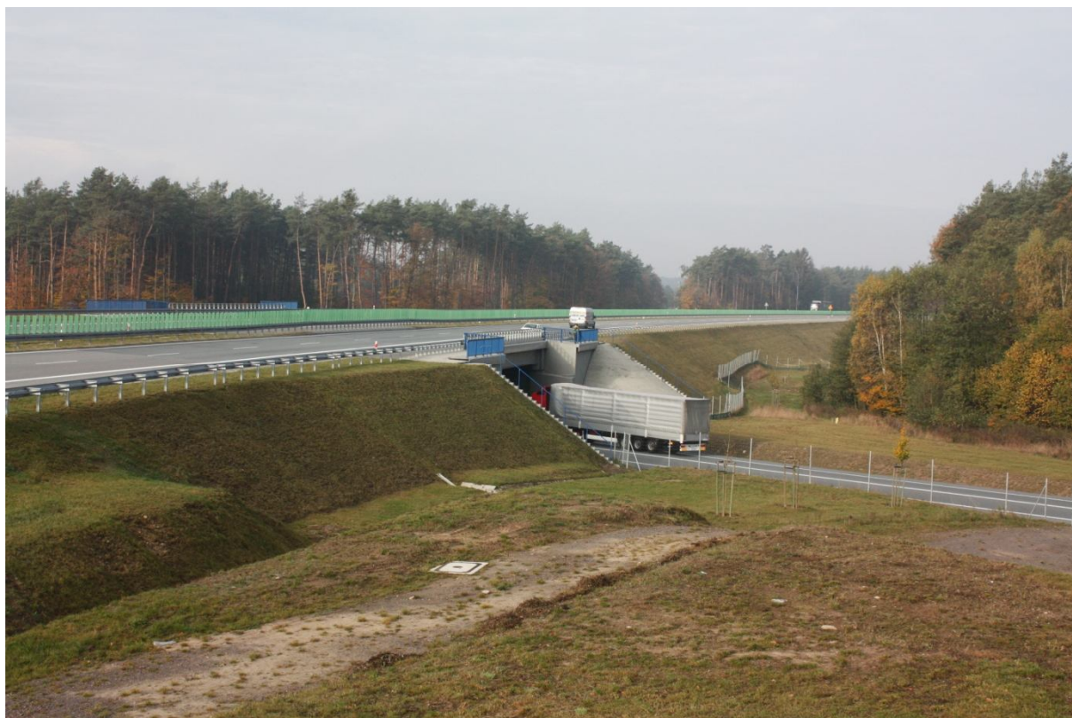
Fot. 2. Widok na autostradę i drogę krajową DK 62 po północnej stronie bramownicy I
