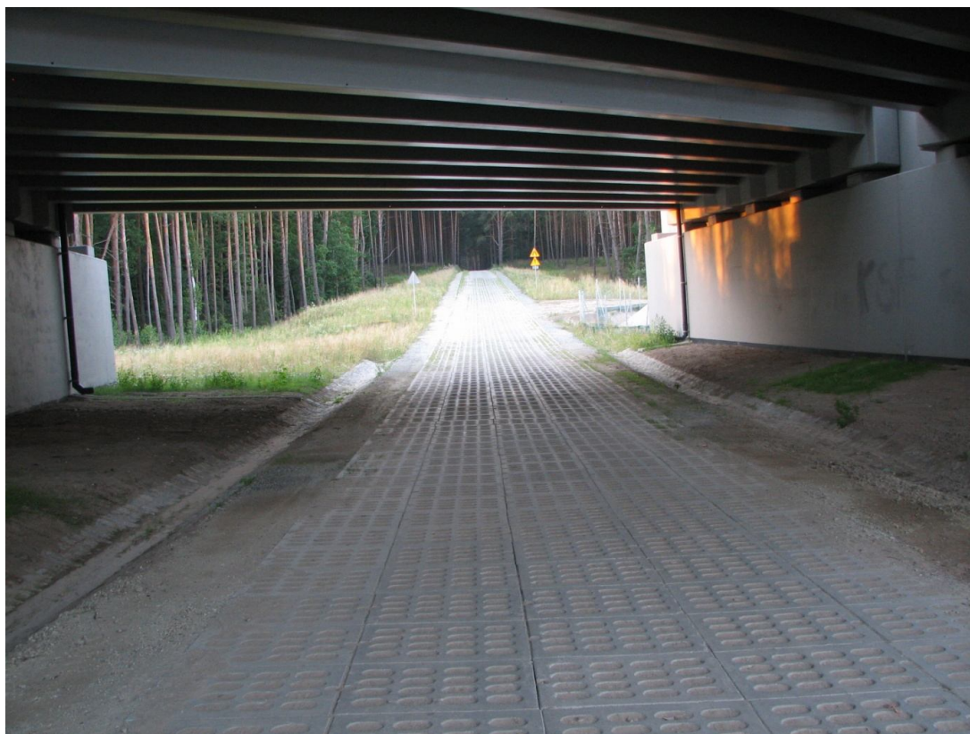
Fot. 10. Przejście dolne WA 39
