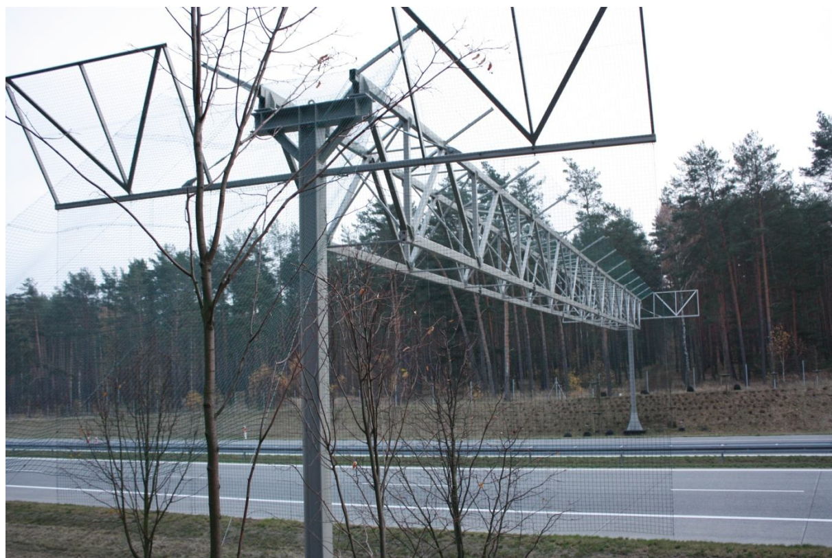
Fot. 4. Bramownica III widok od strony północnej
