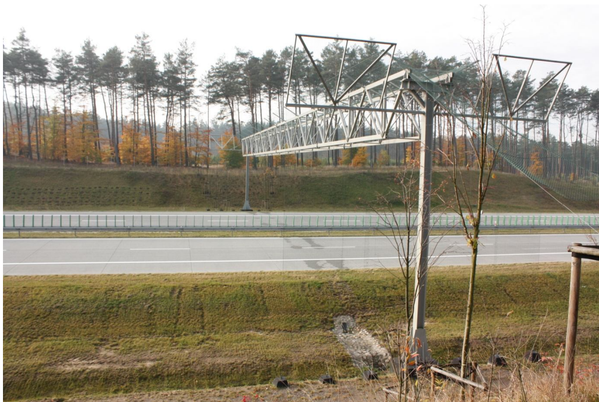
Fot. 1. Bramownica I z widoczną niewielką przecinką po drugiej stronie drogi
