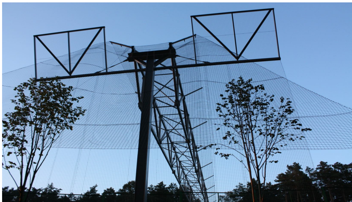
Fot. 5. Bramownica z widocznymi kratownicami mającymi naprowadzać nietoperze na centralną część przejścia
