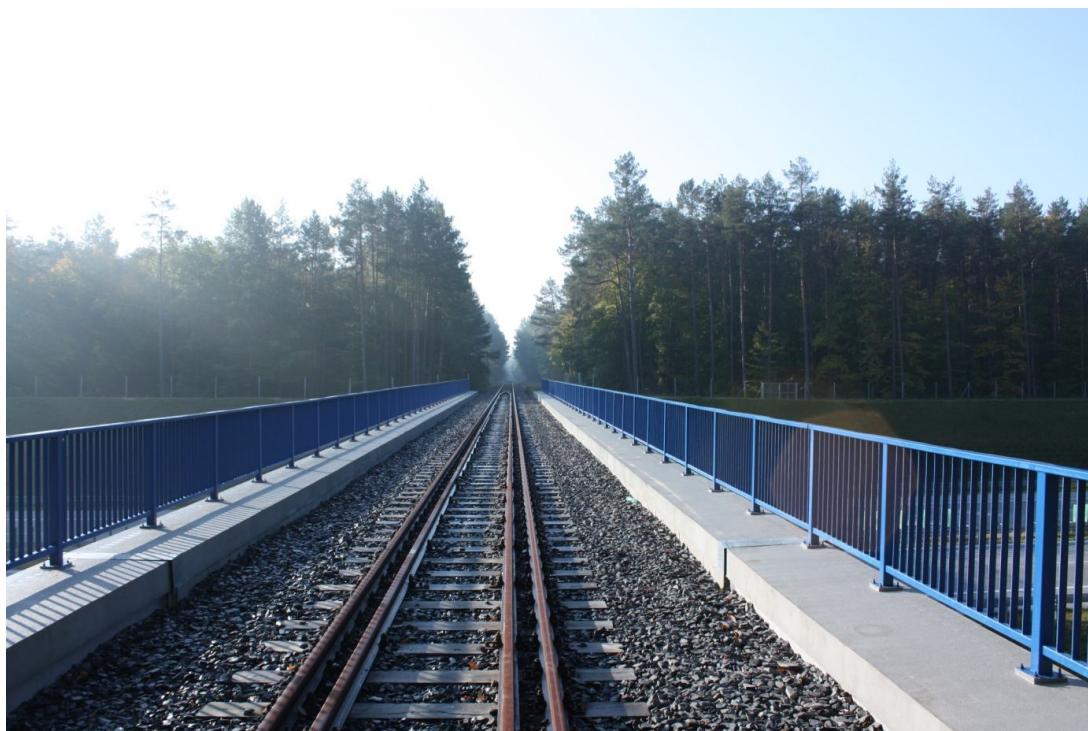
Fot. 8. Wiadukt kolejowy WK – 33
