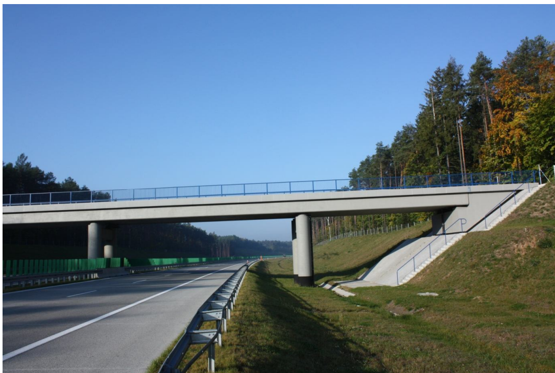
Fot. 6. Wiadukt kolejowy WK – 33
