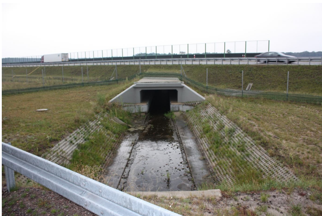
Fot. 11 Obiekt PA 52a – dopływ Gnilej Obry
