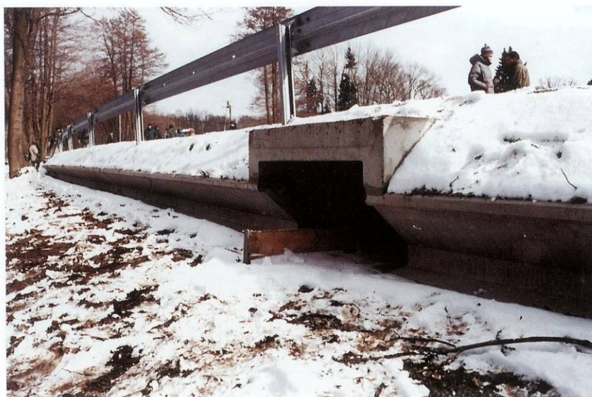
Fot. 4.20.2 Zapora dla płazów z profilowanych prefabrykatów betonowych [93]
