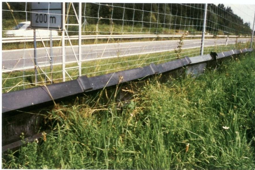
Fot. 4.20.1 Plastikowa zapora wkopana w ziemię i uniemożliwiająca przechodzenie przez drogę płazom i gadom oraz małym ssakom [93]
