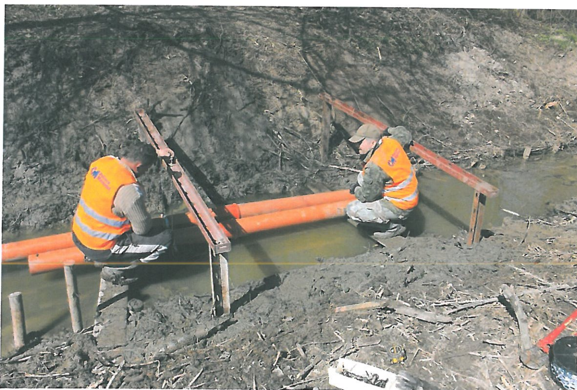
Montaż rur na konstrukcji w okresie płoszenia bobrów (fot. Paweł Nicia)
