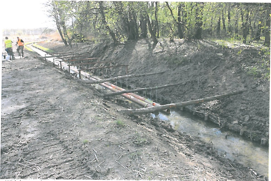
Widok na zabezpieczony ciek po zakończeniu montażu rur na konstrukcji (fot. Paweł Nicia)
