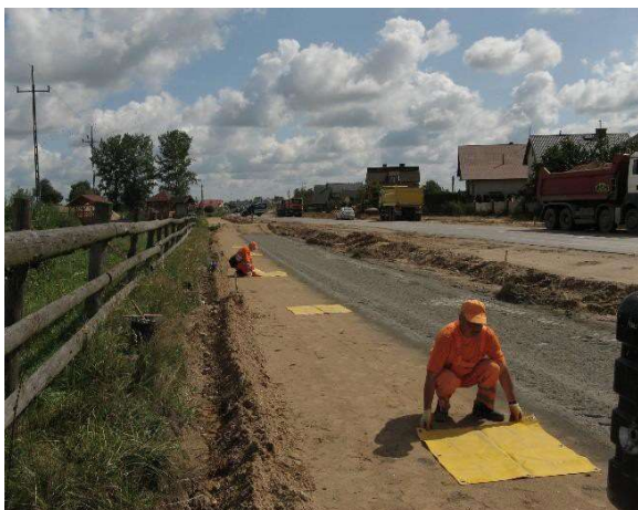
Rozmieszczenie tacek pomiarowych
