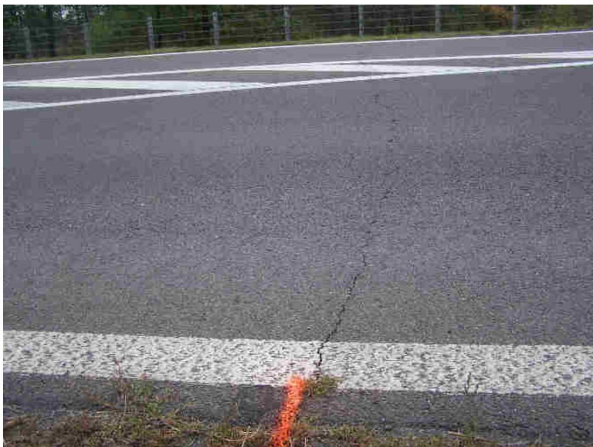
Fot.13 Spękanie poprzeczne jezdni asfaltowej – km 568+245.
