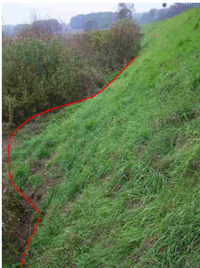
Fot.12 Wybrzuszenie skarpy u podstawy nasypu po południowej stronie nasypu drogowego - km 568+230. Widok od strony wschodniej.
