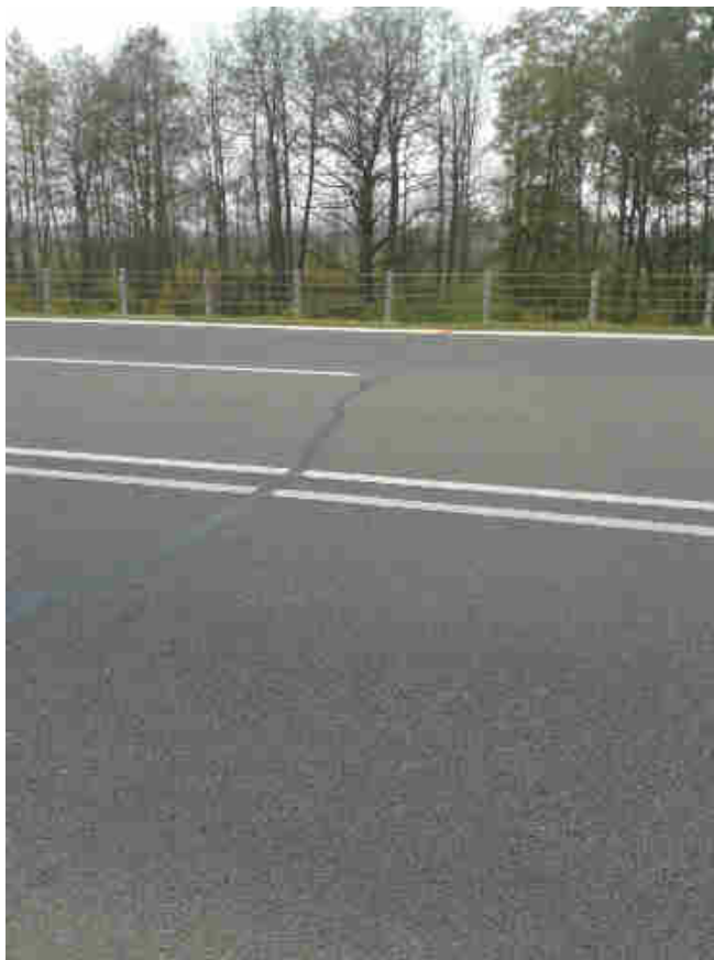
Fot.7 Spękanie poprzeczne jezdni asfaltowej – km 568+170
