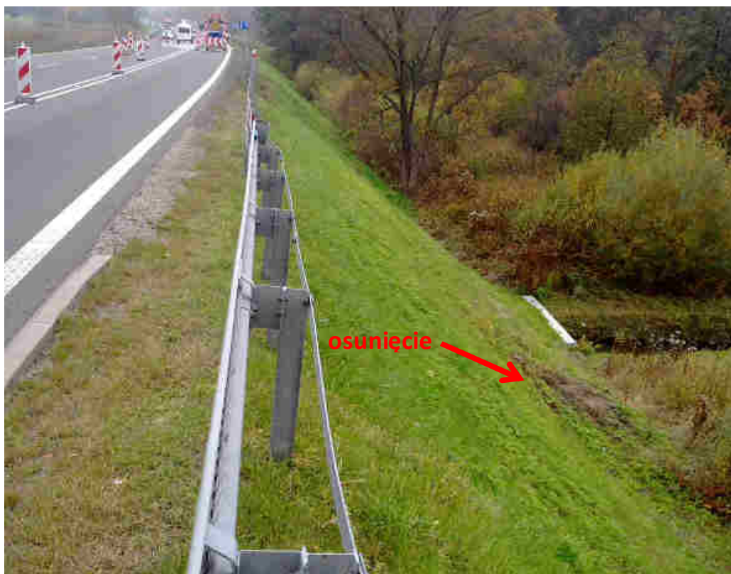
Fot.21 Widok na północną stronę nasypu drogowego wraz z wylotem przepustu – km 568+310. U podstawy skarpy widoczne osunięcie gruntu.
