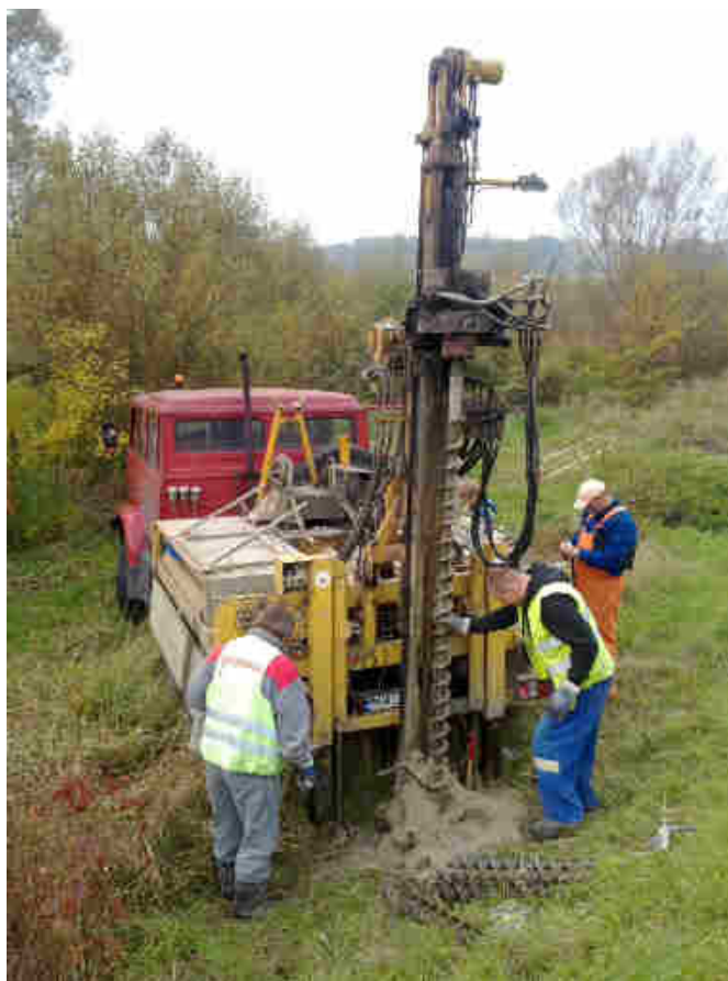
Fot.1 Wiertnica Wamet H25-S na podwoziu STAR 266 wykonująca wiercenie badawcze nr OW-3
