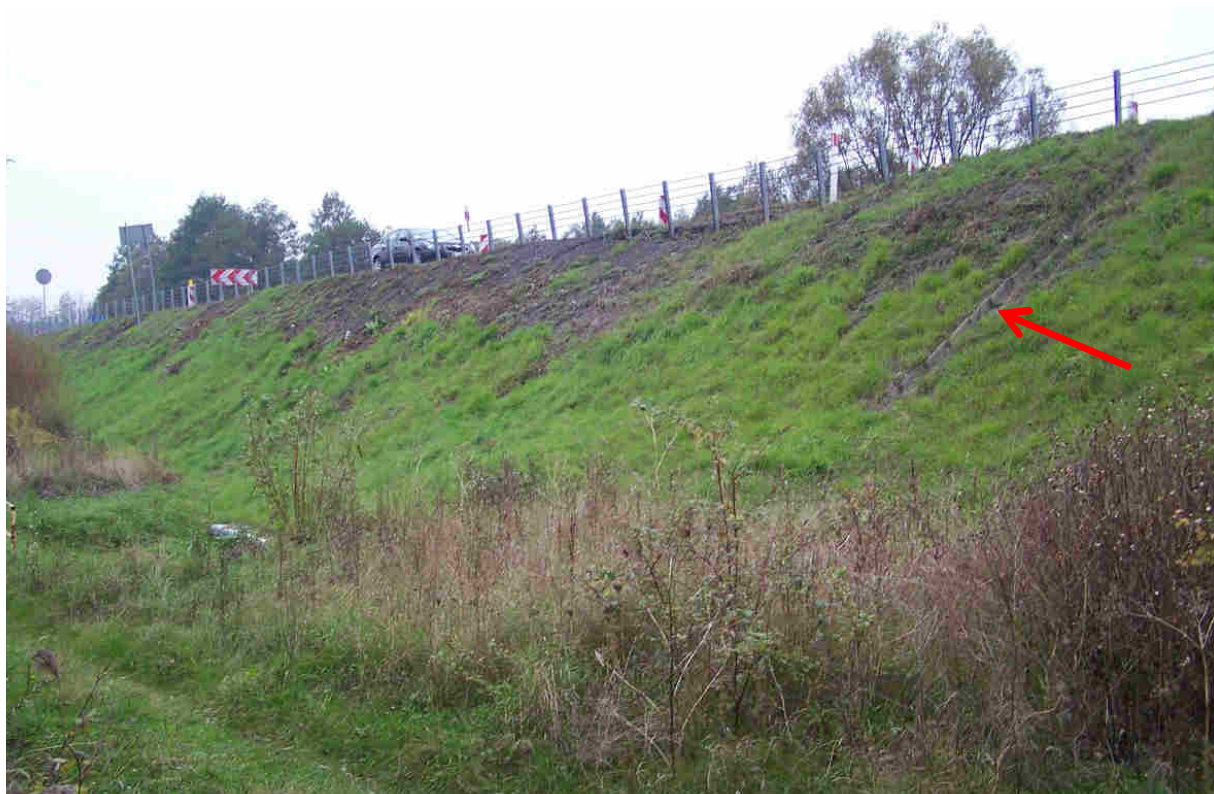
Fot.19 Widok na południową stronę nasypu drogowego - km 568+300. Widoczne doraźne wzmocnienia górnej części skarpy asfaltem, oraz niedrożne koryto odprowadzające wody opadowe z jezdni.
