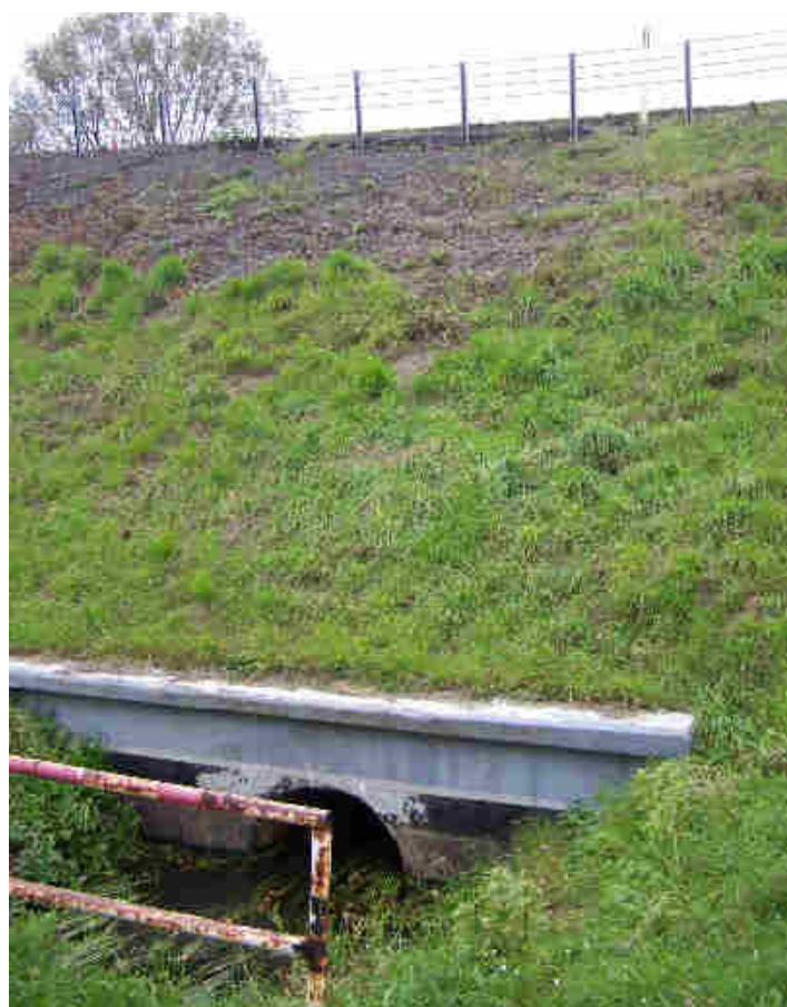
Fot.20 Widok na południową stronę nasypu drogowego - km 568+310. Widoczny wlot przepustu oraz miejsce osunięcia pobocza.
