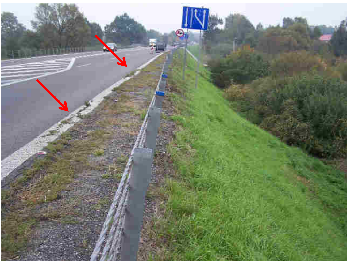
Fot.11 Widok na południową stronę nasypu drogowego, widoczne spękania krawędzi nawierzchni na odcinku 568+210 ÷ 568+236 km, wzmocnione pobocze warstwą asfaltową oraz wybrzuszenie skarpy u podstawy nasypu w km 568+230.
