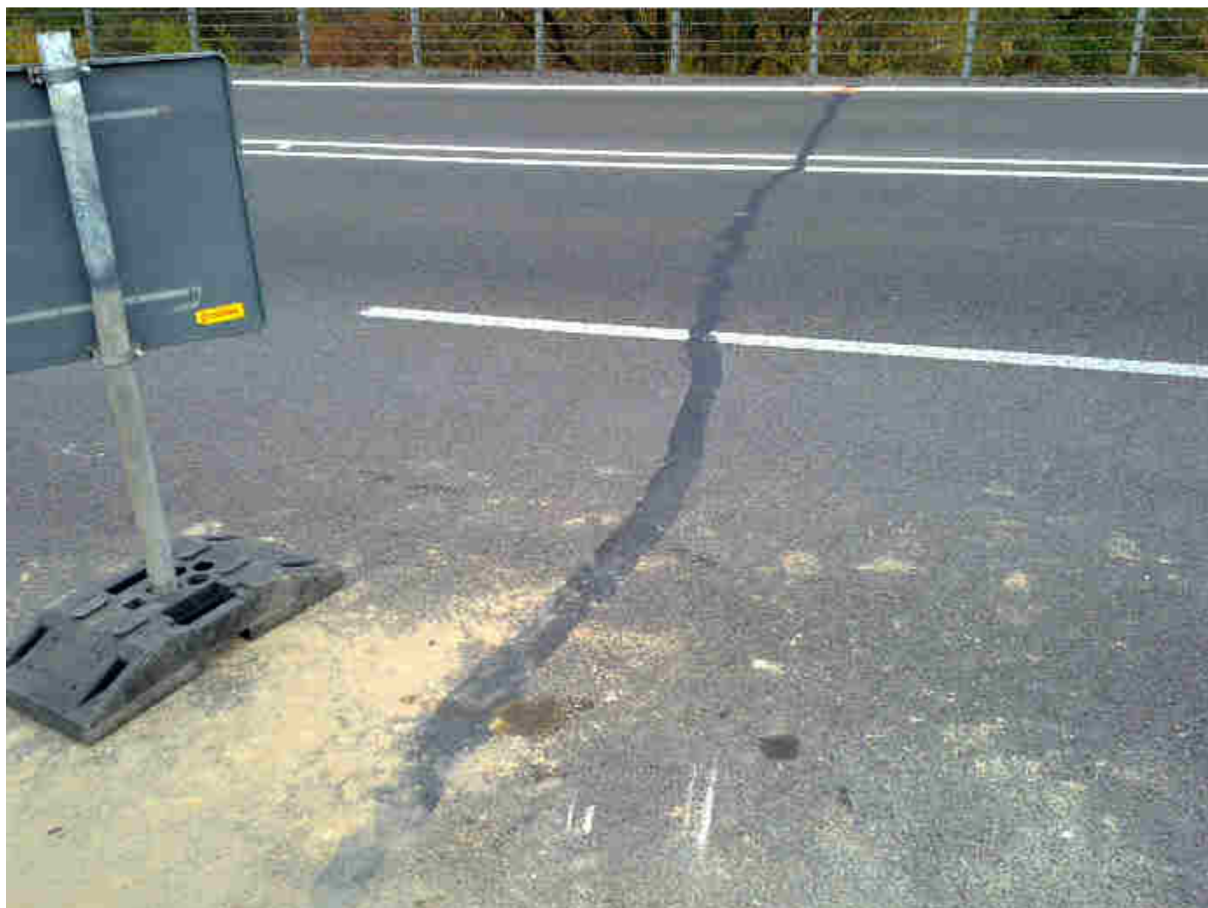
Fot.16 Spękanie poprzeczne jezdni asfaltowej – km 568+297.
