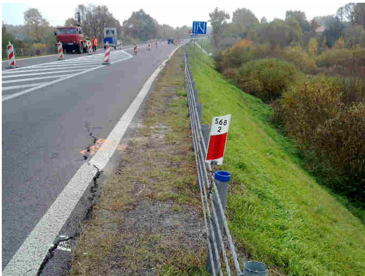
Fot.9 Silne spękanie krawędzi jezdni asfaltowej po stronie południowej – km 568+199÷568+208, wzmocnione pobocze.
