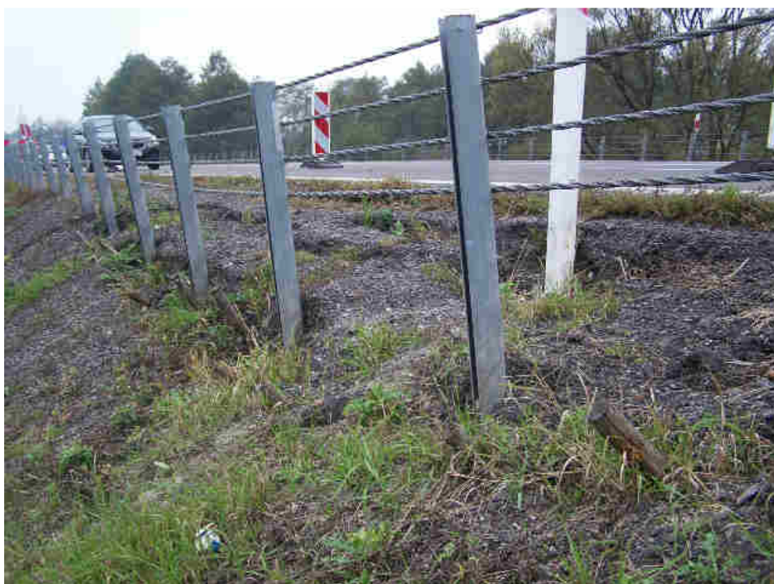
Fot.18 Osunięcie pobocza zlokalizowane po południowej stronie nasypu drogowego - km 568+310. Widoczne doraźne zabezpieczenie faszyną i asfaltem.
