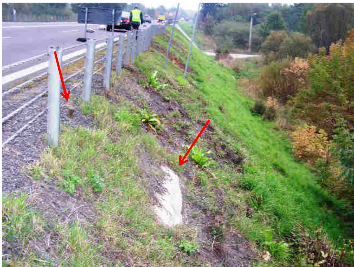
Fot.14 Wzmocnienie skarpy asfaltem, faszyną oraz miejscowo blokiem betonowym zlokalizowane po południowej stronie nasypu drogowego - km 568+264. Widoczne wyraźne osiadania linowej bariery ochronnej.
