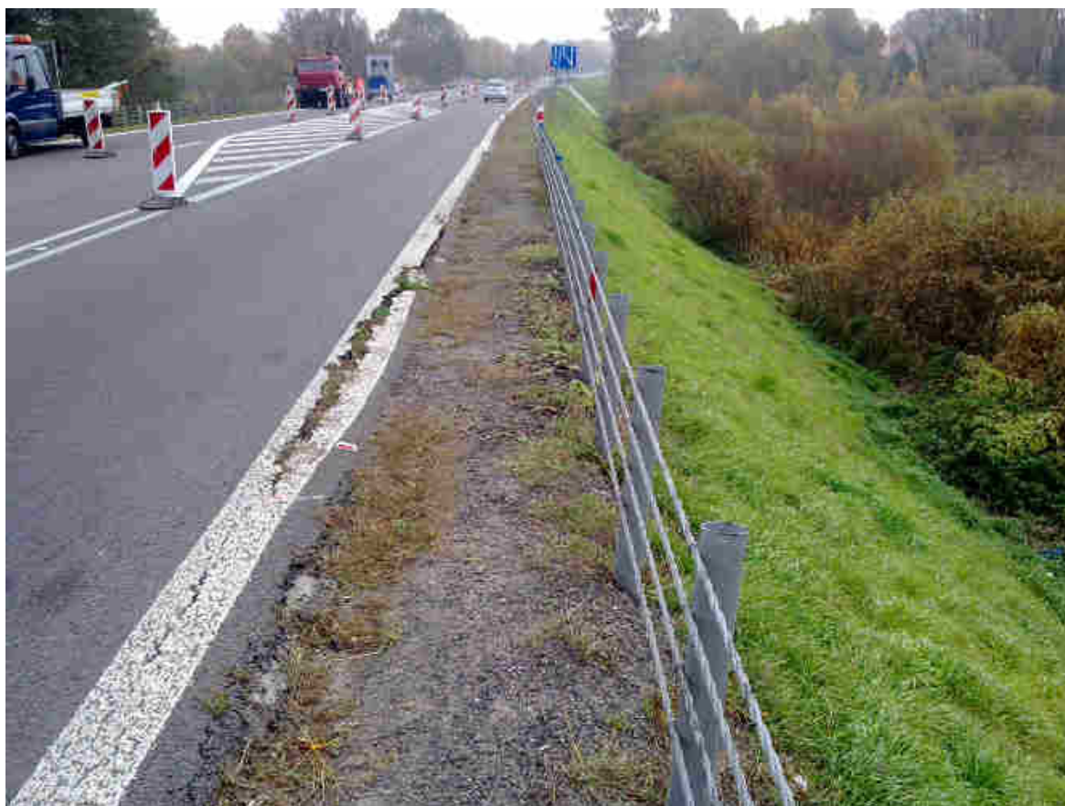
Fot.8 Widok na południową stronę nasypu drogowego, widoczne spękania krawędzi nawierzchni na odcinku 568+178 ÷ 568+189 km, oraz wzmocnione pobocze warstwą asfaltową na odcinku 568+170 ÷ 568+340 km.
