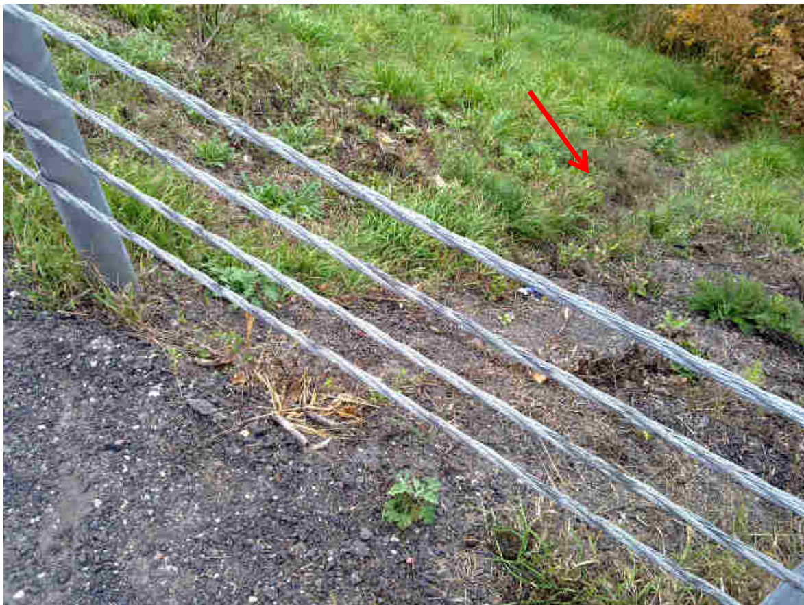
Fot.15 Niedrożne koryto odprowadzające wody opadowe z jezdni, zlokalizowane po południowej stronie nasypu - km 568+274.
