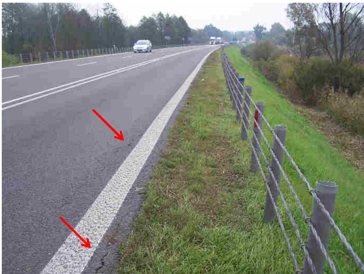
Fot.5 Widok na południową stronę nasypu drogowego, widoczne spękania krawędzi nawierzchni km 568+070
