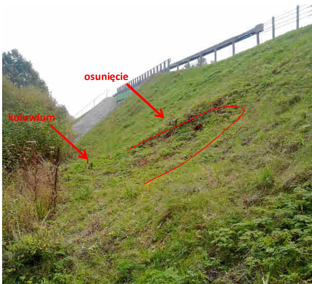
Fot.22 Widok na północną stronę nasypu drogowego – km 568+320. U podstawy skarpy widoczne osunięcie gruntu.
