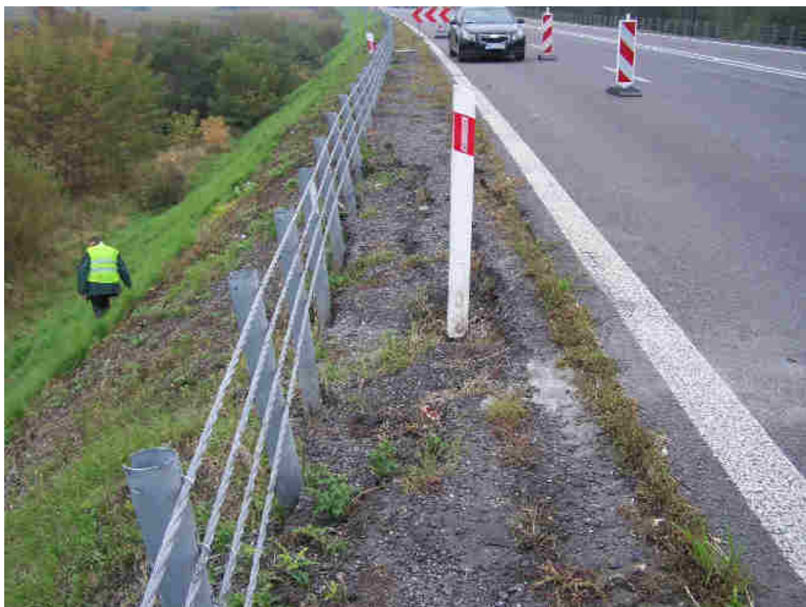
Fot.17 Osunięcie pobocza zlokalizowane po południowej stronie nasypu drogowego - km 568+305÷568+314. Widoczne wyraźne odchylenie linowej bariery ochronnej od pionu.
