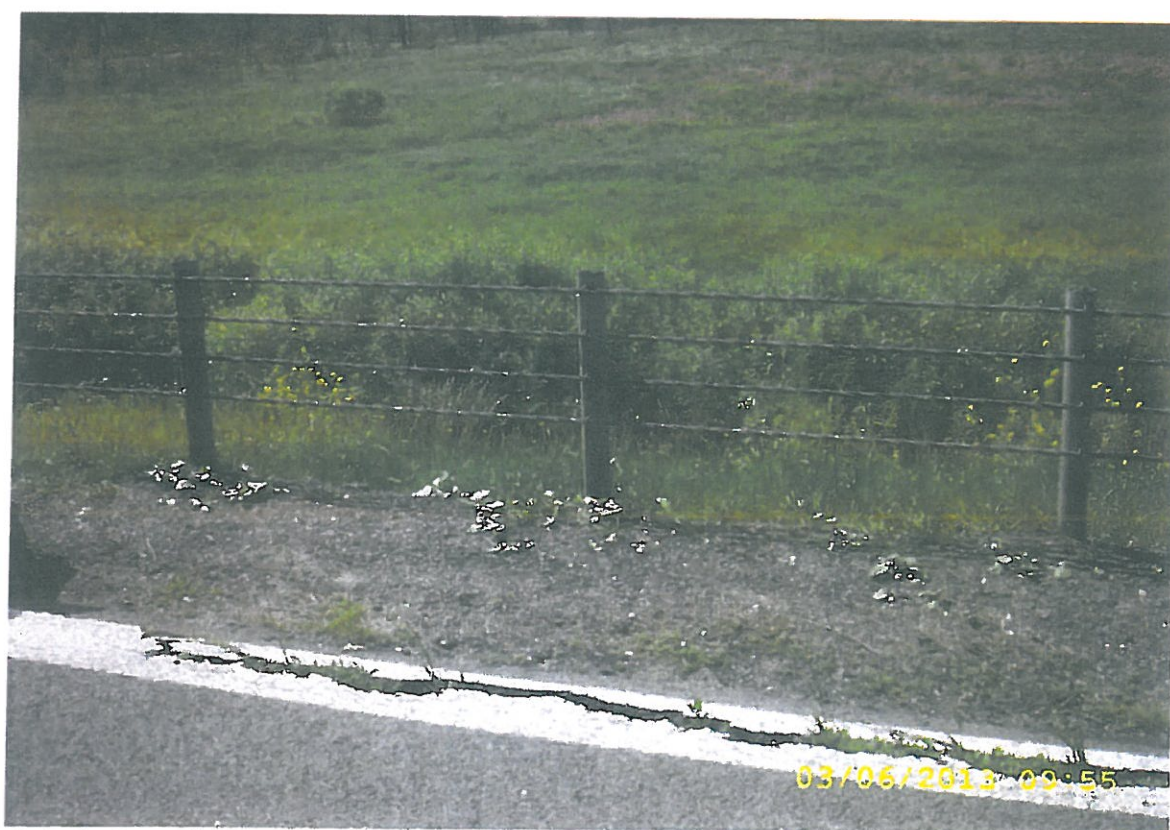
Pęknięcia podłużne krawędzi jezdni świadczące i degradacji skarpy nasypu.
