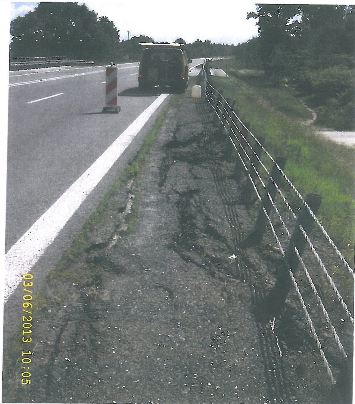
Pobocze drogi, mimo cyklicznych napraw i uzupełnień wykazuje uszkodzenia o charakterze osuwiskowym.
