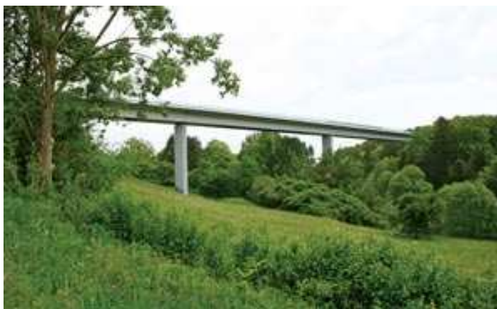
Rysunek 2.18 Przejście dolne pod estakadą, autostrada A98 w Niemczech (pracownia.org.pl)
