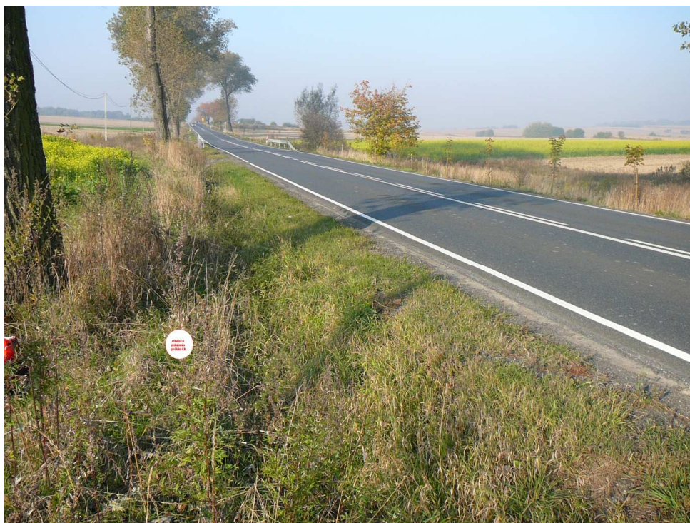
Fotografia 5.2 Miejsce poboru próbki przy nawierzchni porowatej (próbka CN)
