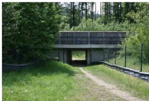
Rysunek 2.20 Przejście dla małych zwierząt połączone z przejazdem gospodarczym – zwraca uwagę prawidłowe urządzenie obiektu: gruntowa nawierzchnia drogi, osłony antyolśnieniowe, płotki naprowadzające dla płazów (pracownia.org.pl)
