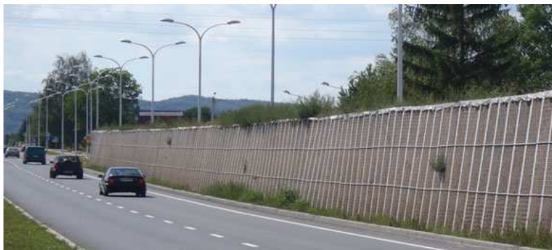
Rysunek 2.6 Przykład ziemnego ekranu akustycznego wzdłuż ul. Krakowskiej w Katowicach (edroga.pl)
