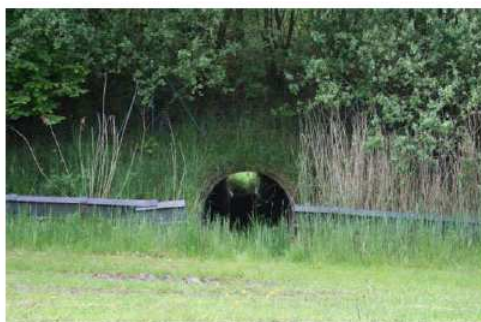
Rysunek 2.21 Przepust dla płazów i małych ssaków o przekroju owalnym (pracownia.org.pl)
