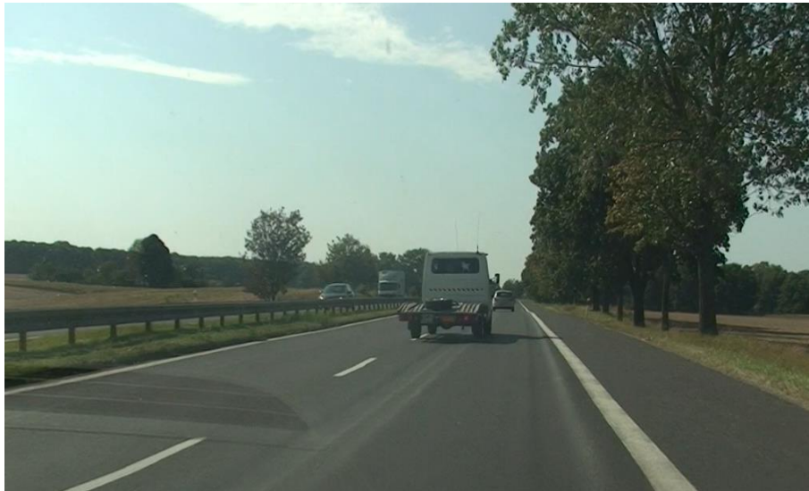
Rysunek C.31. Koleina o głębokości ok. 30 mm na prawym pasie jezdni w kierunku Iwna km 213+300
