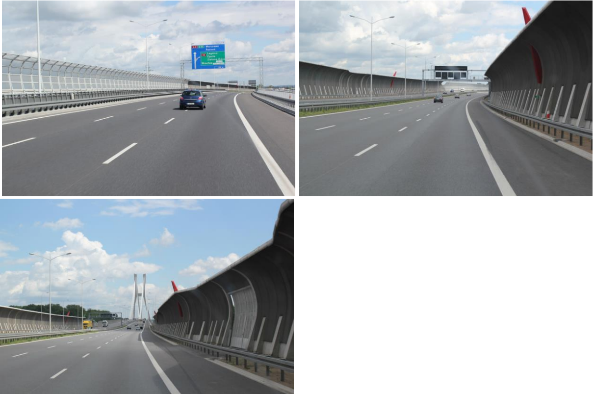
Rysunek C.2. Stan nawierzchni odcinka A8 oceniony w roku 2012
