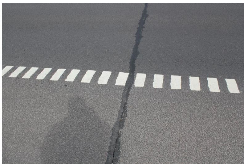
Rysunek C.15. Stan nawierzchni odcinka DK8 oceniony w roku 2012 (otwarte naprawy spękań poprzecznych)
