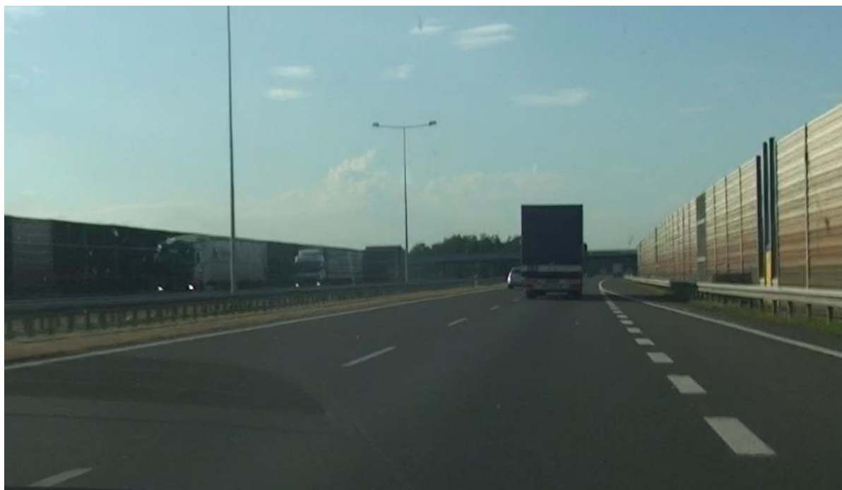
Rysunek C.21 Widok nawierzchni autostrady A2 na odcinku Konin - Koło- Nowe Dąbie, brak istotnych uszkodzeń nawierzchni
