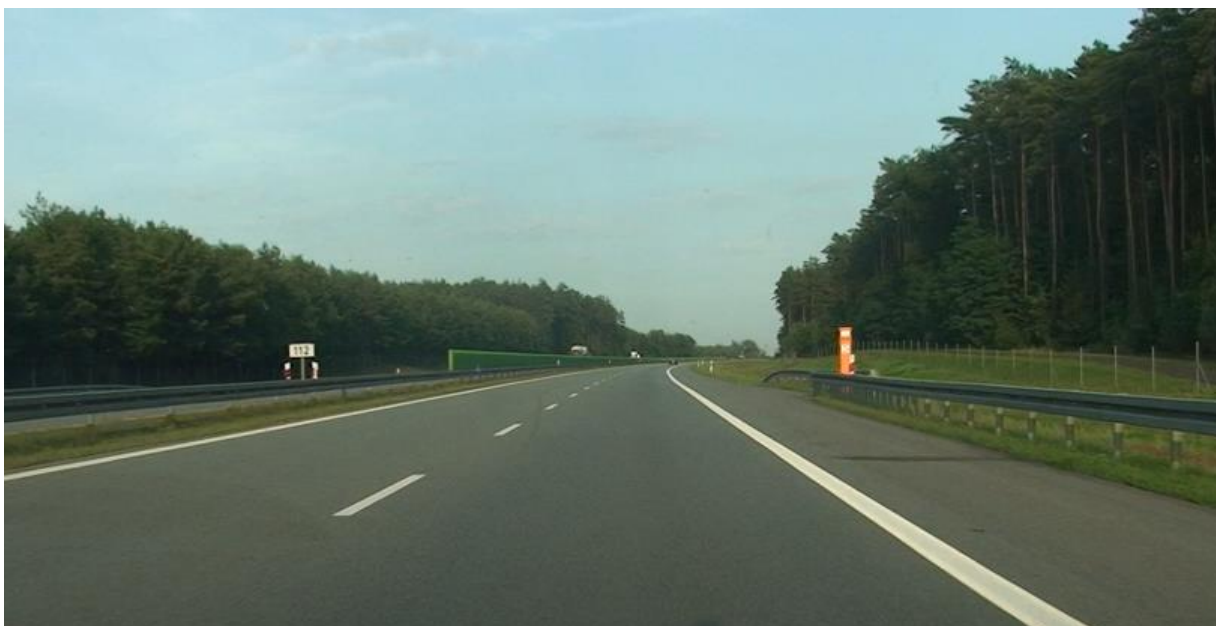
Rysunek C.20. Widok nawierzchni autostrady A2 na odcinku Komorniki - Nowy Tomyśl, brak uszkodzeń na całym odcinku
