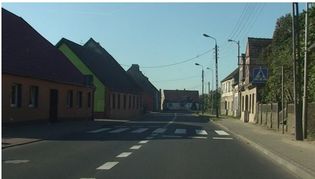
Rysunek C.35. Odcinek DK 10 w Mirosławcu, brak zaobserwowanych, znaczących uszkodzeń.
