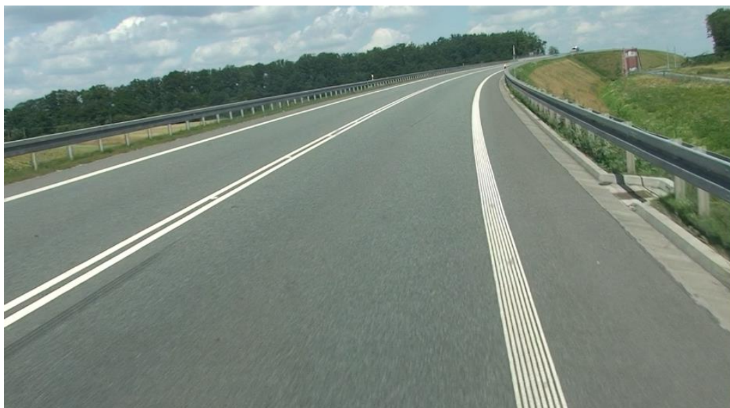
Rysunek C.24 Widok nawierzchni na drodze S11 Obwodnica Ostrowa Wielkopolskiego. Bardzo dobry stan techniczny na całym odcinku drogi.
