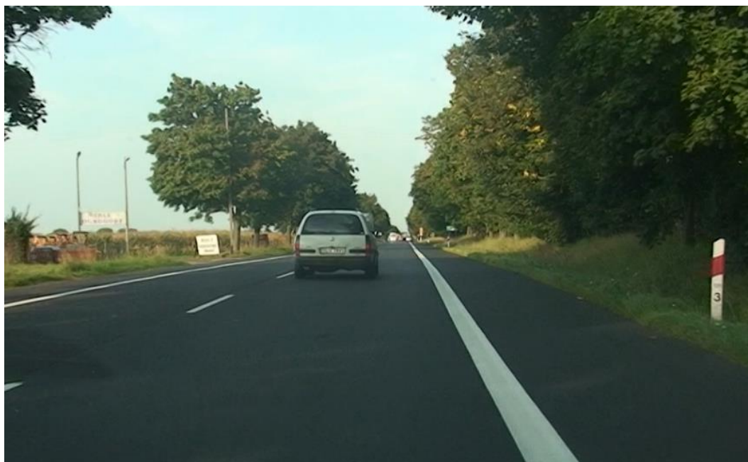
Rysunek C.29. Widok nawierzchni drogi krajowej nr 92 km 120+300
