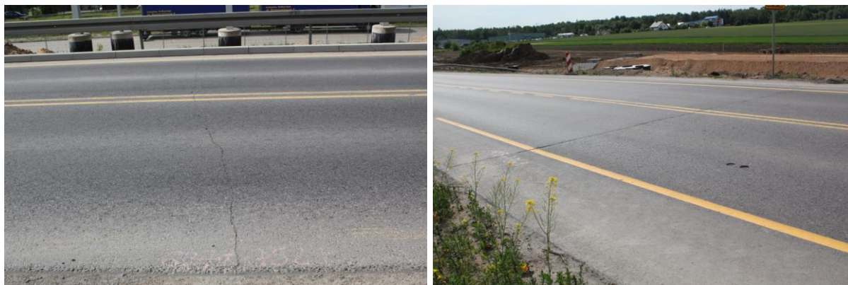
Rysunek C.10. Stan nawierzchni odcinka S8 oceniony w roku 2012 a) spękanie poprzeczne o średnim rozwarciu; b) otwarty szew roboczy
