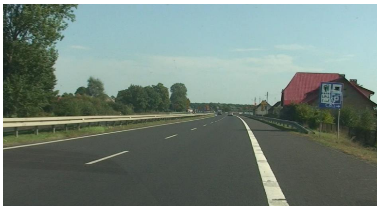
Rysunek C.33. DK 92 spękanie poprzeczne przez całą szerokość jezdni w km 219+900
