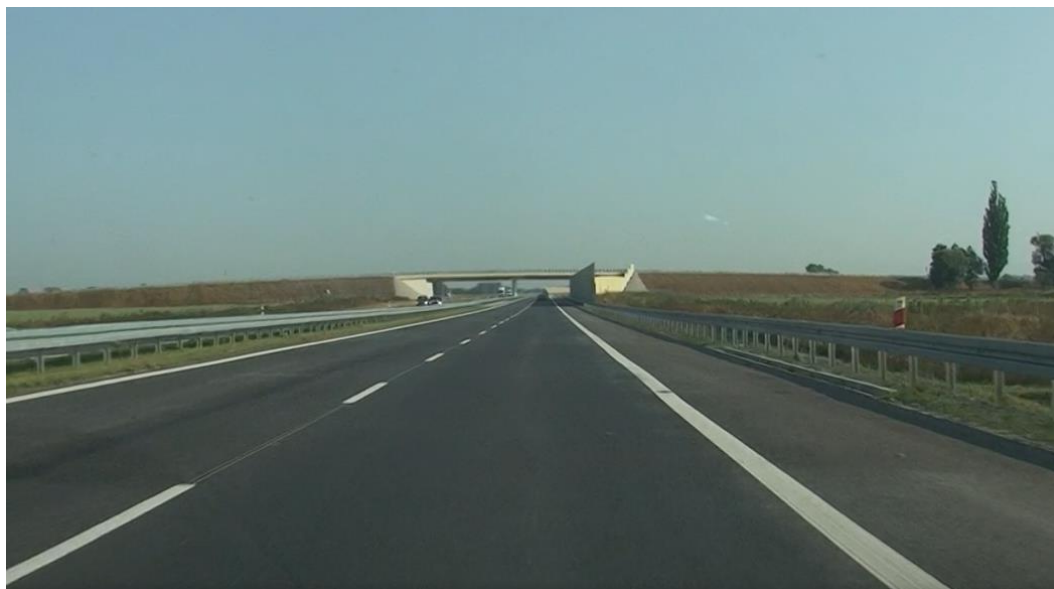
Rysunek C.22. Stan nawierzchni drogi S5, km 34+300
