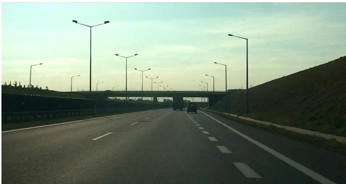
Rysunek C.19. Widok nawierzchni autostrady A2 na odcinku Komorniki - Krzesiny, dobry lub bardzo dobry stan techniczny na całym odcinku drogi
