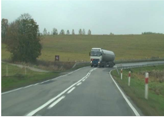
Fot. 5.7. Łuk poziomy o małym promieniu w planie – widok w kierunku Szczytna
