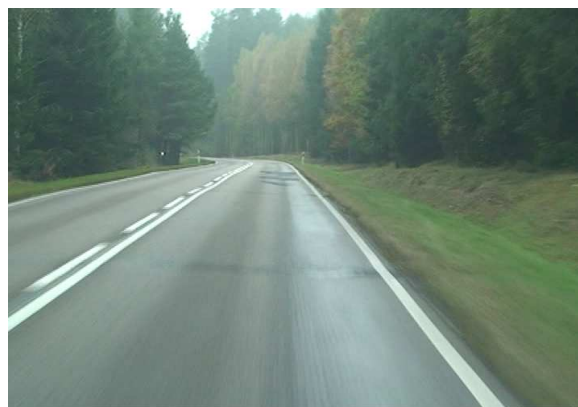
Fot. 5.14 . Koniec odcinka – widok w kierunku Pasymia
