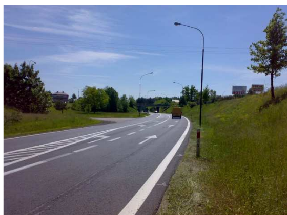
Fot. 3.7 Skrzyżowanie z DW 803 – wlot od strony Warszawy
