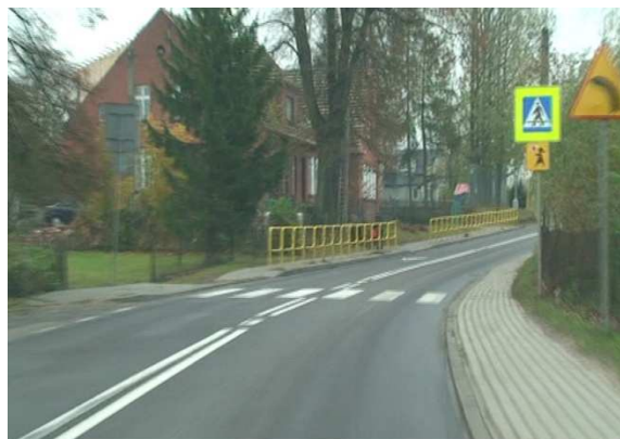
Fot. 5.5 . Przejście dla pieszych w miejscowości Grom
