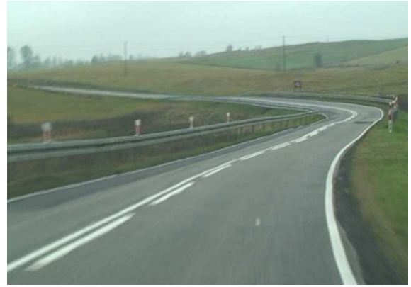
Fot. 5.8. Łuk poziomy w małym promieniu w planie – widok w kierunku Pasymla
