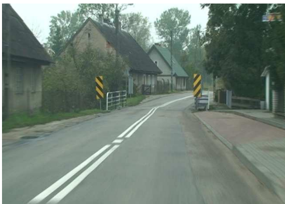
Fot. 5.9. Most o zawężonej skrajni poziomej – miejscowość Jęcznik
