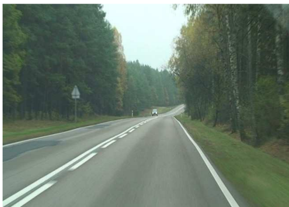
Fot. 5.13 . Koniec odcinka – widok w kierunku Szczytna
