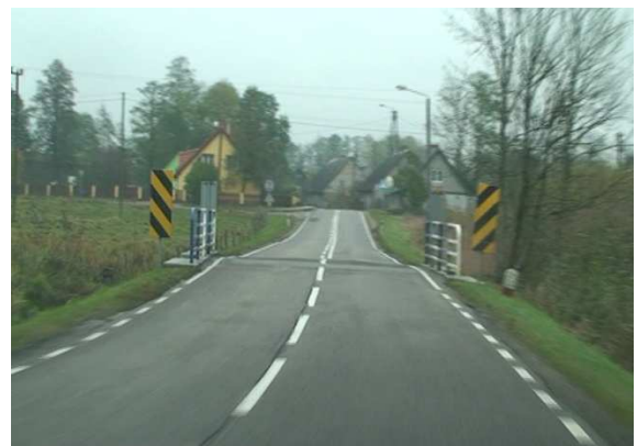
Fot. 5.10. Most o zawężonej skrajni poziomej – miejscowość Jęcznik
