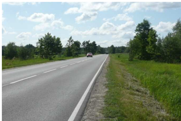
Fot. 4.16 Koniec analizowanego odcinka
