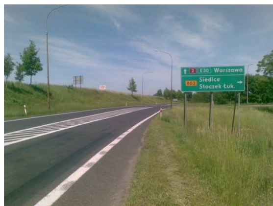
Fot. 3.8 Skrzyżowanie z DW 803 – wlot od strony Terespoła
