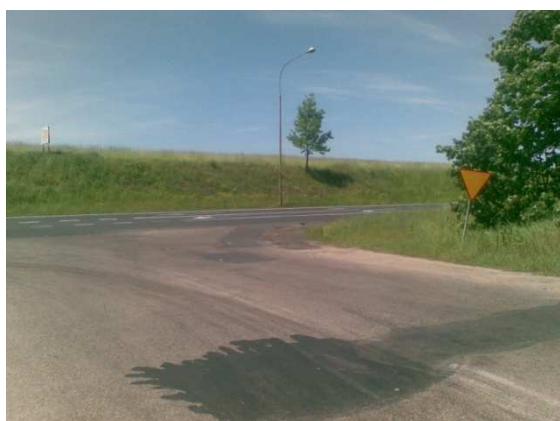
Fot. 3.9 Skrzyżowanie z DW 803 – wlot od strony Stoczka Łukawskiego
