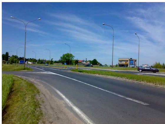
Fot. 3.5 Skrzyżowanie DK 2 z drogą powiatową
