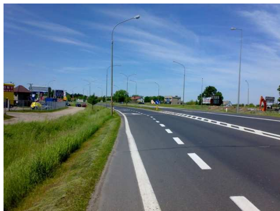
Fot. 3.6 Początek analizowanego odcinka
