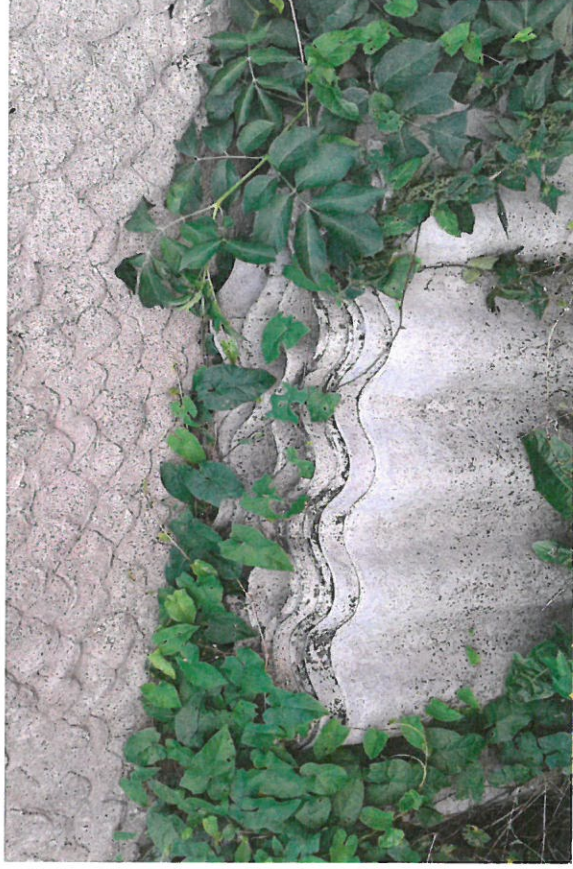
Fot. 4 Płyty zgromadzone przy altance
