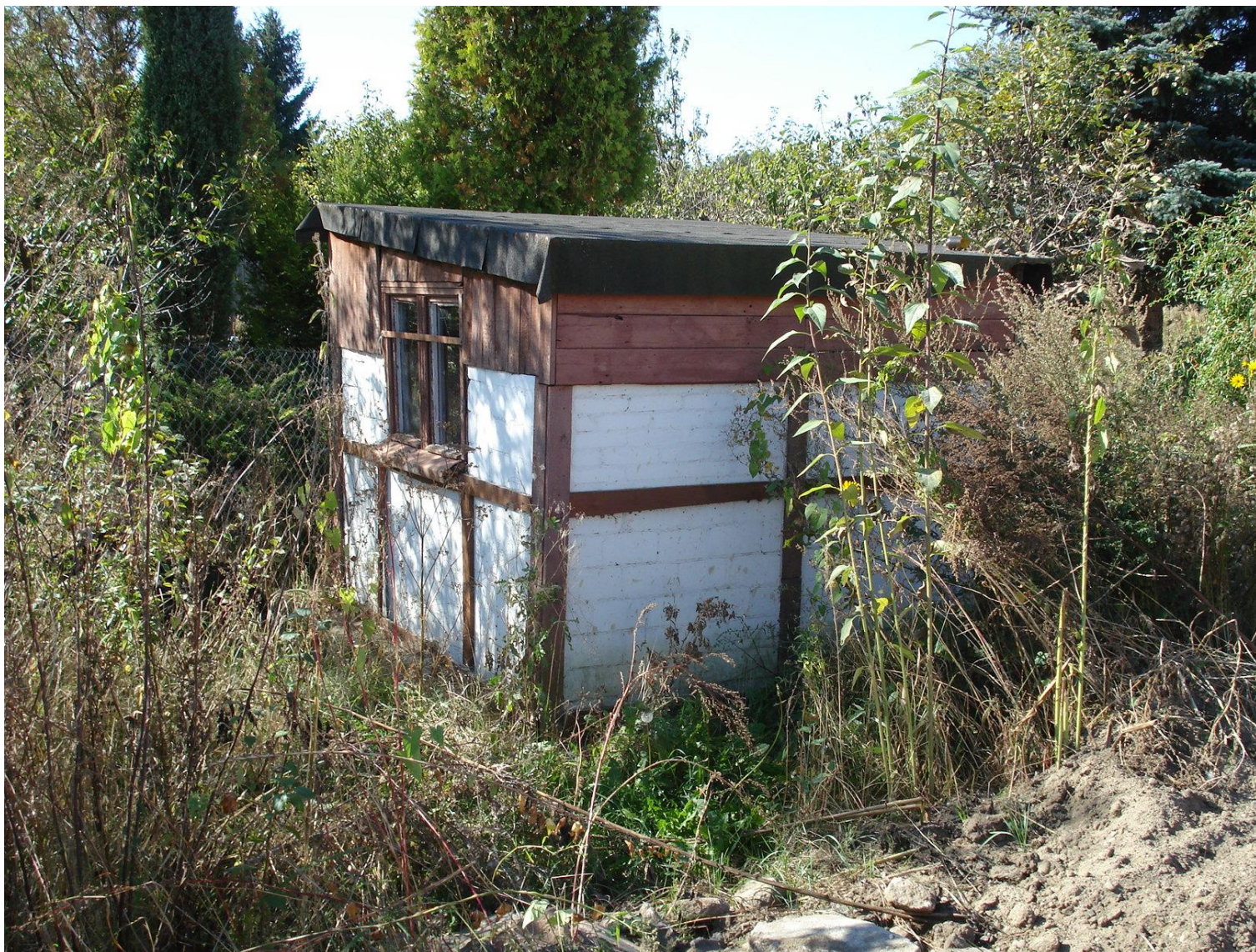
6. Obiekt nr 6 - Altana ogrodowa w km 9+810 strona prawa obwodnicy, działka o nr 1090/18, obręb Zakanale
