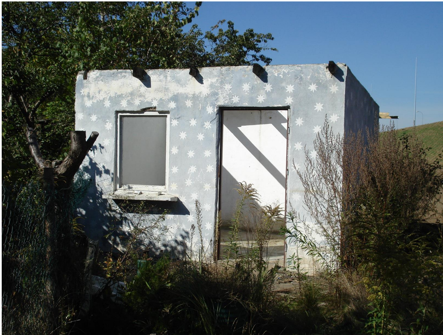
7. Obiekt nr 7 - Altana ogrodowa w km 9+960 strona prawa obwodnicy, działki o nr 1090/18, 1090/19 obręb Zakanale
