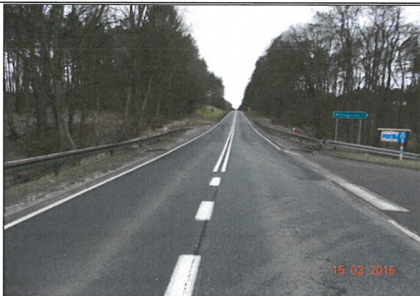
Fot. 4 Widok nawierzchni
