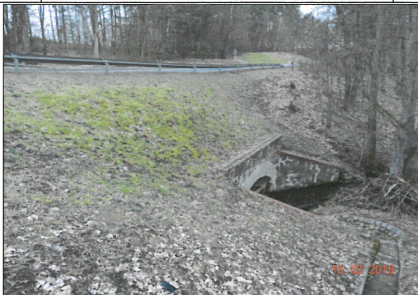
Fot. 1 Widok ogólny obiektu
