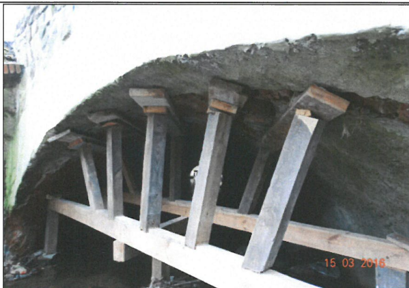
Fot. 8 Zabezpieczenie obiektu tymczasową konstrukcją wsporczą, podpierającą łuk mającą na celu niedopuszczenie do utraty stateczności obiektu.
