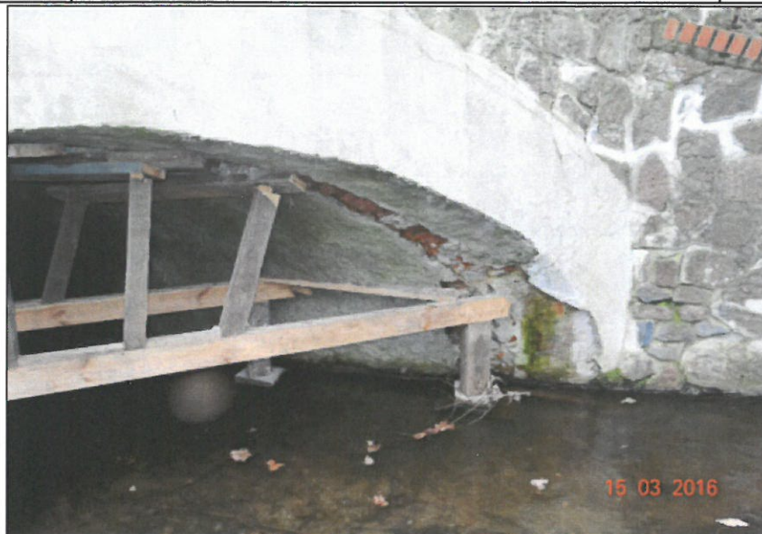
Fot. 7 Zabezpieczenie obiektu tymczasową konstrukcją wsporczą, podpierającą łuk mającą na celu niedopuszczenie do utraty stateczności obiektu.
