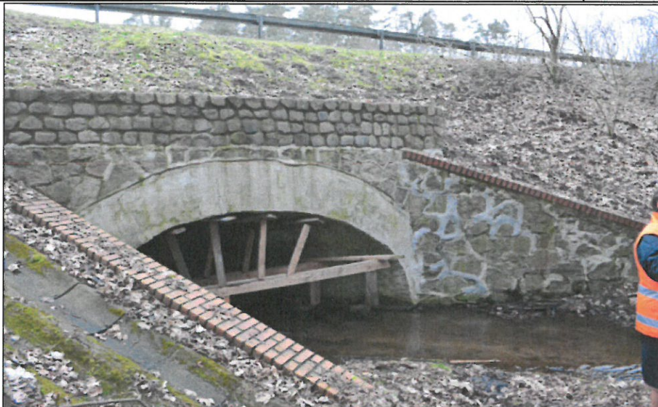
Fot. 3 Widok obiektu z boku strona prawa
