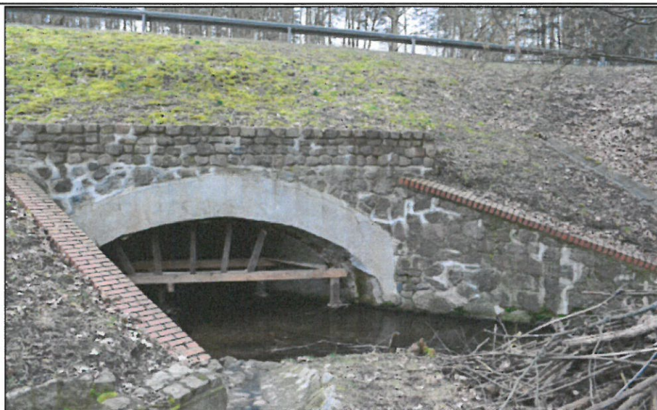
Fot. 2 Widok obiektu z boku strona lewa
