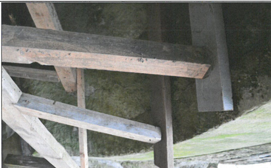
Fot. 12 Tymczasowa konstrukcja wsporcza zabezpieczająca obiekt przed utratą stateczności.
